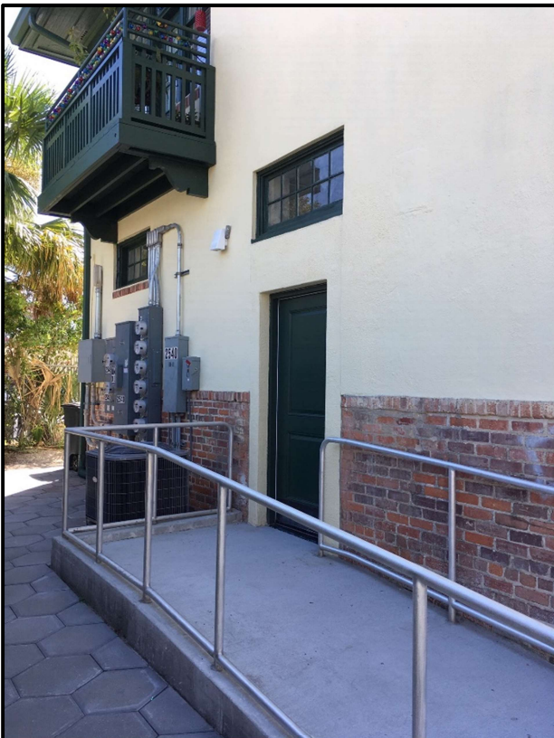
New ADA ramp access to tenant space
